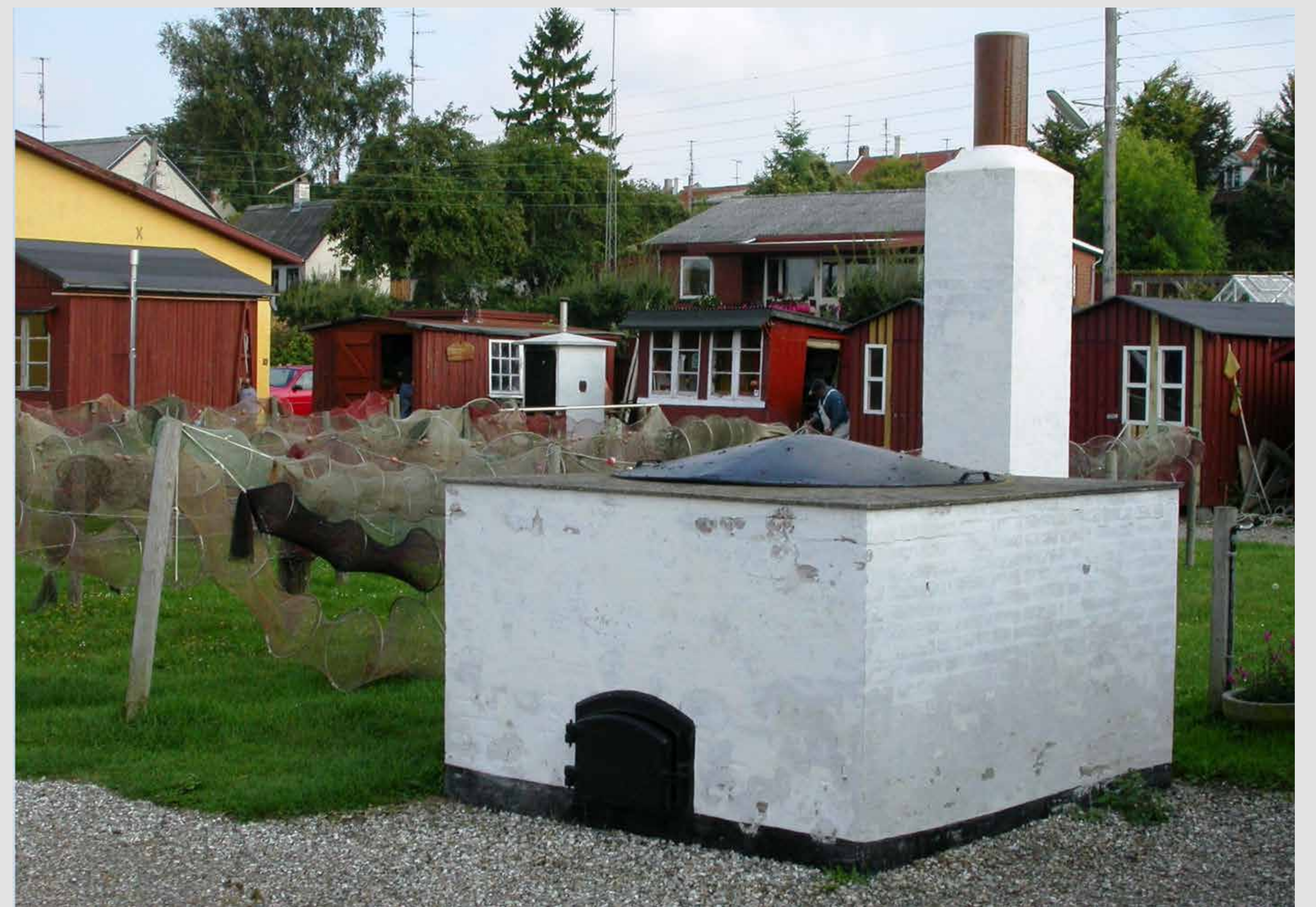
Den nordvästra barkpannan vid Nysted hamn har av frivilliga restaurerats och tagits i drift. Bilden är från före restaureringen. Foto: Ole Wiberg.
